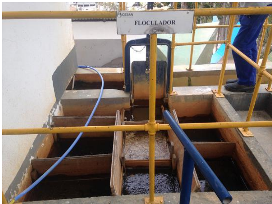
Quadro 25 - Características da ETA.
