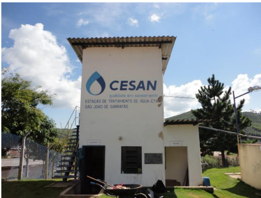
Figura 37 – ETA São João do Garrafão.
